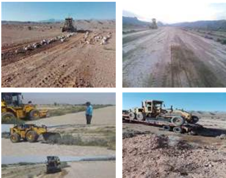
شکل ۴-۳- اصلاح و مرمت فرودگاه‌های سمپاشی در شهرستان‌های استان
