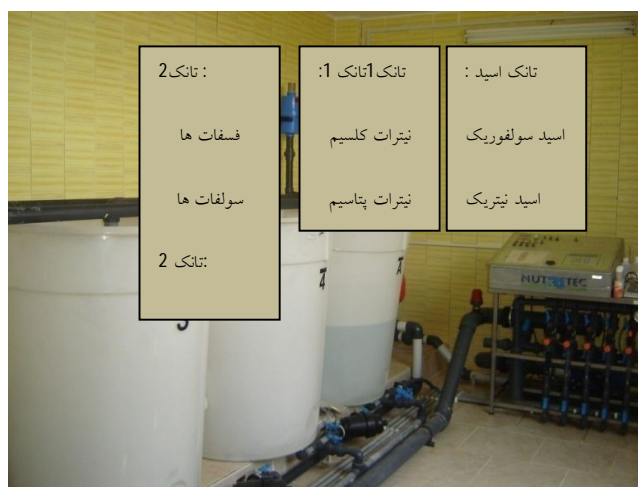
شکل 47- استفاده از تانک‌های مجزای مواد کودی به منظور جلوگیری از ترسیب کودهای ناسازگار در روش کود آبیاری
