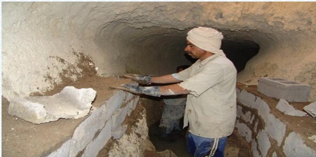
شکل ۳- عملیات احیاء و مرمت کوره قنات شمس آباد طشک بختگان
